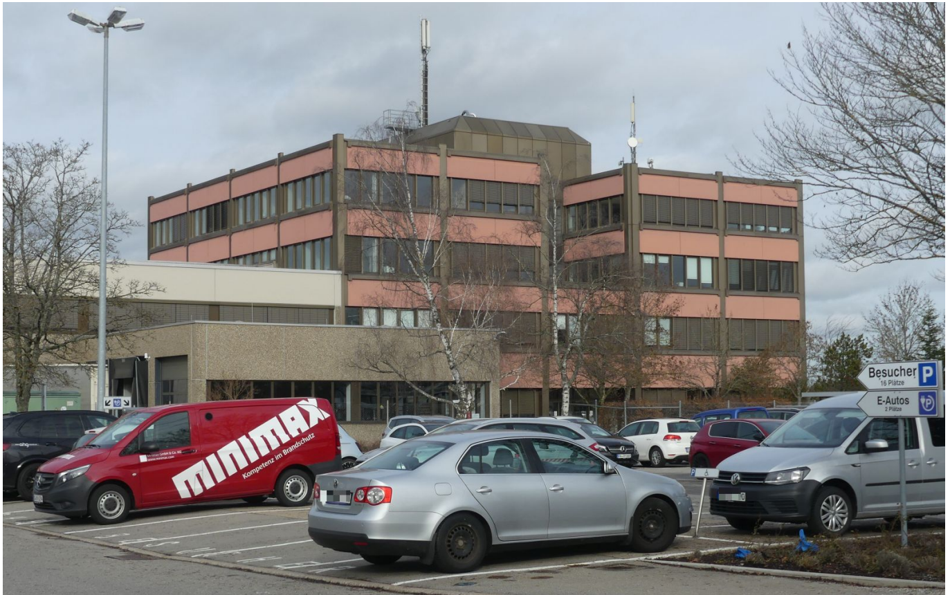
Firmenzentrale in Sulgen. Foto: him
